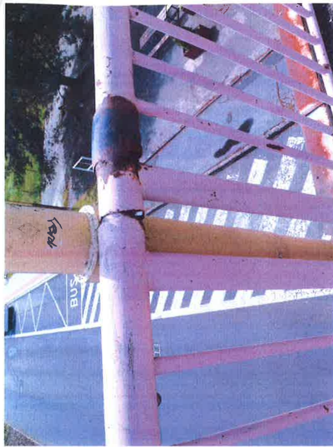
Dilatační spoj zábradlí
