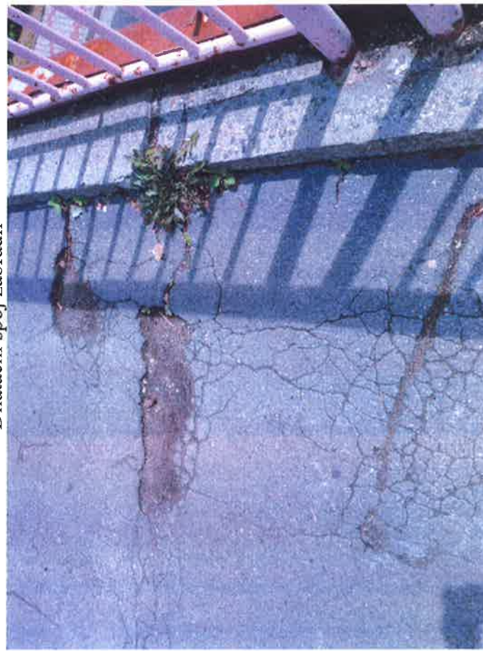
Rozpadlý povrch mostovky
